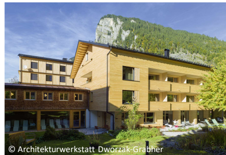
Hotel Krone Au - Sanierung und Zubau
